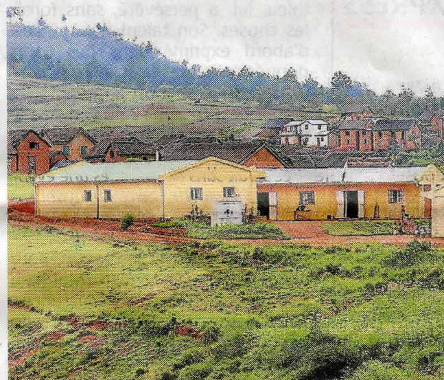
L'école d'Ambohitsoa dispose de trois bâtiments neufs.
